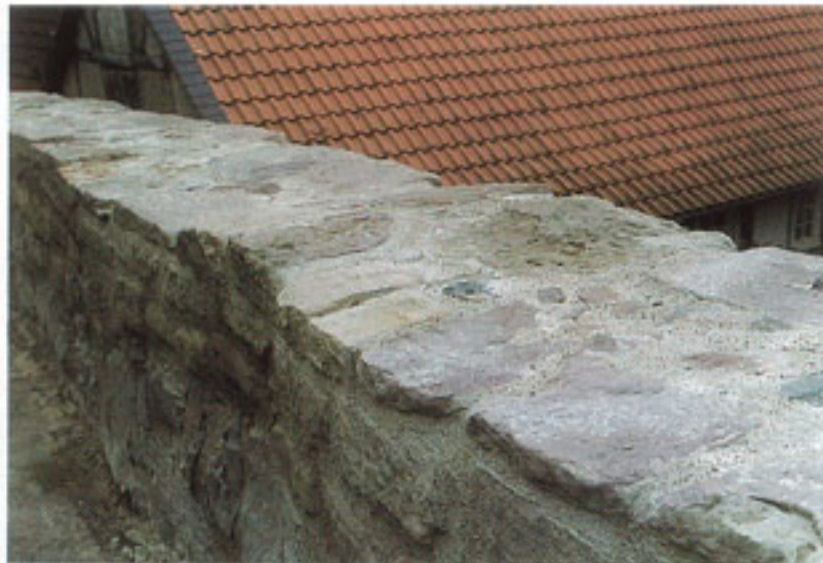
Alte Mauer aus Buntsandstein (Obergrenzebach) nach der Sanierung.
